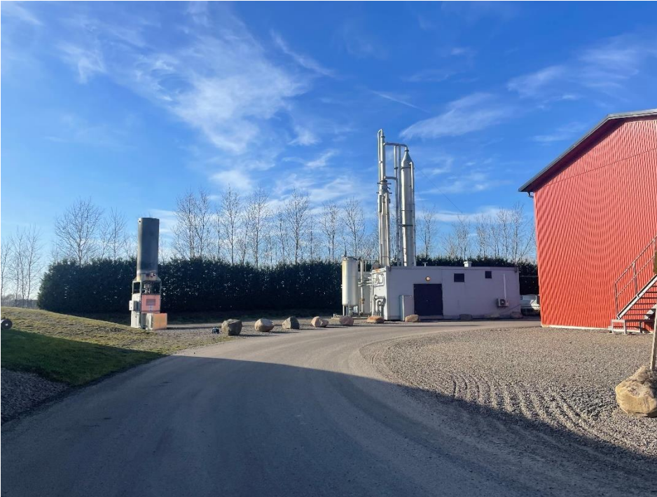
Figur 15. Gasuppgradering (till höge) och fackla (till vänster).
