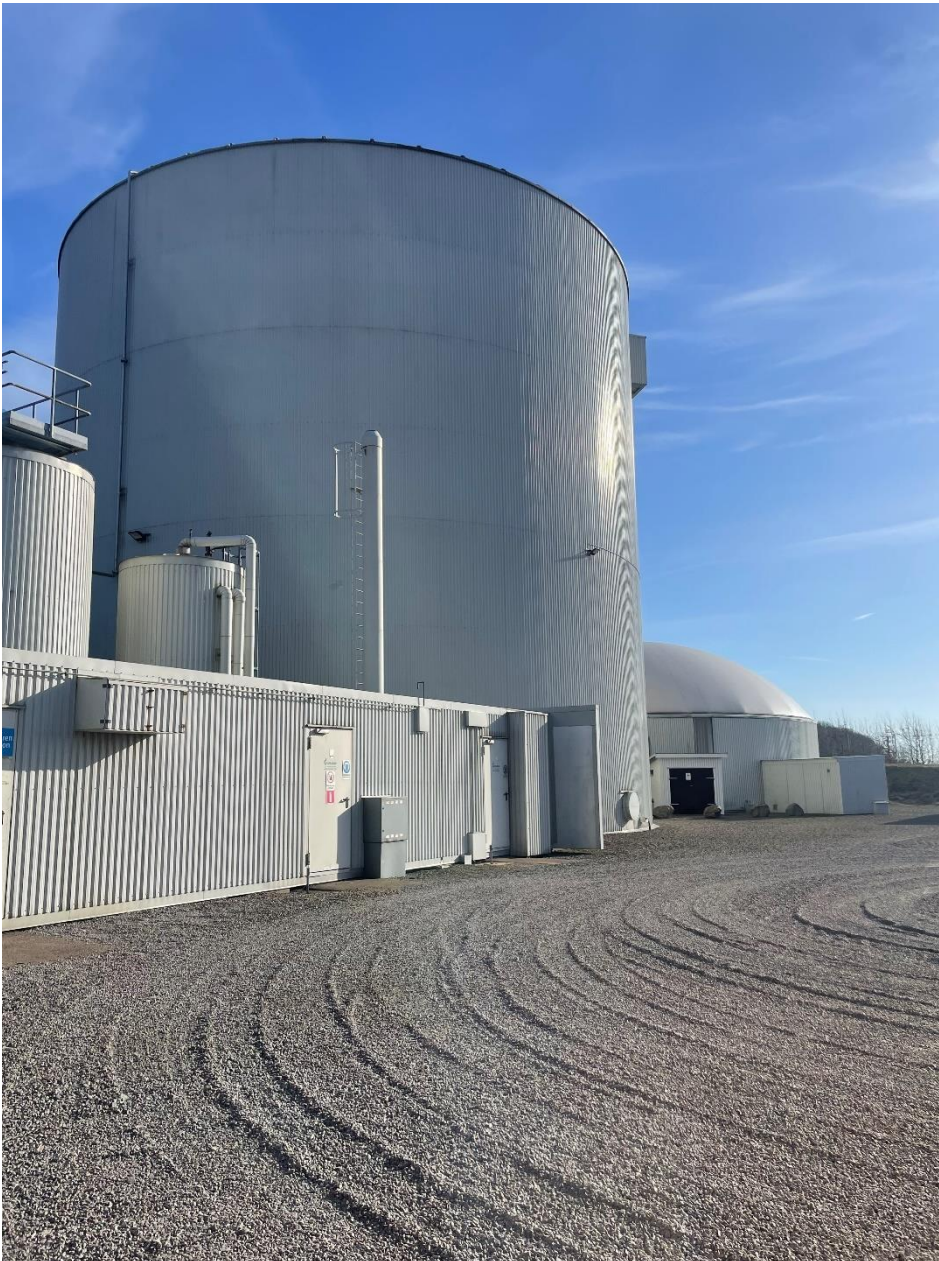
Figur 13. Röt-kammare med hygieniseringstankar (till vänster) och efterröt-kammare (till höger)
