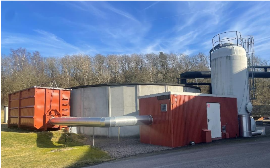
Figur 11. Luktreningsanläggning med biofilter.
