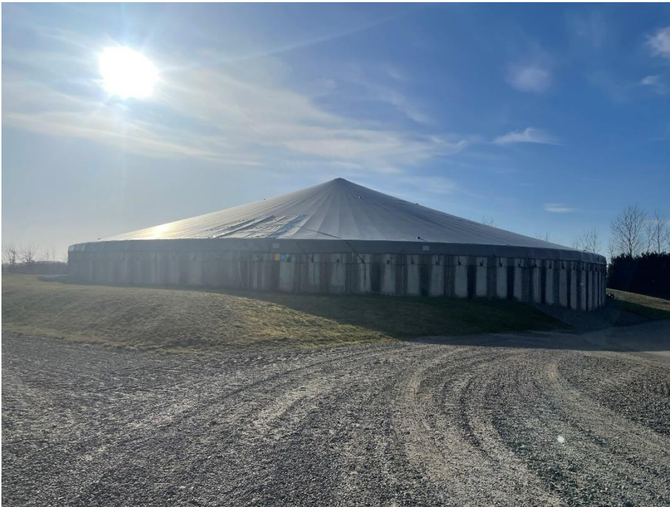
Figur 14. Lagertank för biogödsel.
