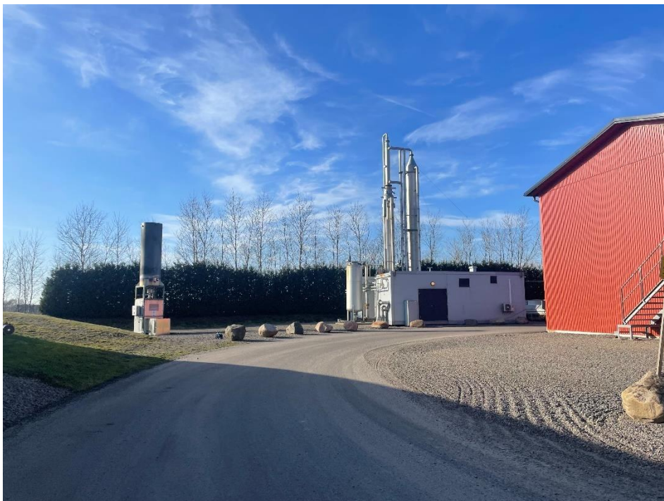
Figur 15. Gasuppgradering (till höger) och fackla (till vänster).
